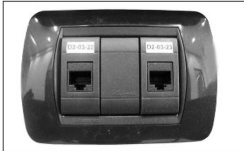
La **presa a muro** o **placchetta**, relativa al singolo posto di lavoro (WA), deve contenere due o più cavi, di cui almeno uno deve essere di tipo UTP a 4 coppie di categoria 3 o superiore. Il cavo UTP va intestato in una presa **RJ45**. All'interno della presa deve esserci un secondo cavo, che può essere un qualunque dei cavi ammessi per il cablaggio orizzontale. Nella maggior parte dei casi è un cavo UTP CAT5.
